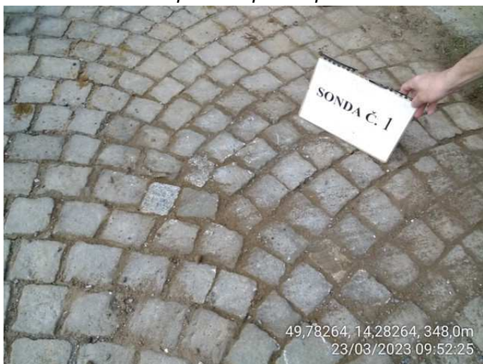
Sonda č.1 – zpětná úprava povrchu
